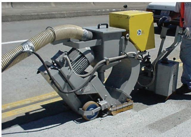
Fig. 3.3.2.1.2—Shotblasting.
