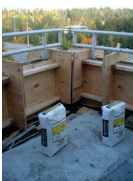
Fig. 5.3.2a—Form-and-pour method.
