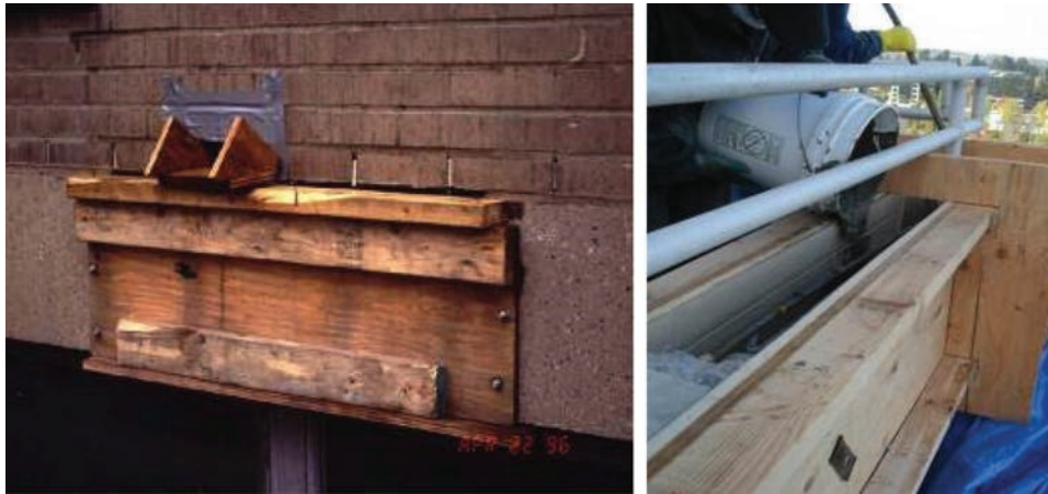
Fig. 5.3.2b—Form-and-pour method.
